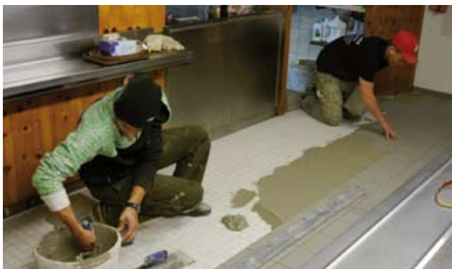
Fleißige Helfer bei der Küchensanierung
